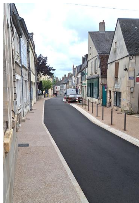
Les travaux du Centre Bourg continuent et avancent comme prévu conformément au planning.
